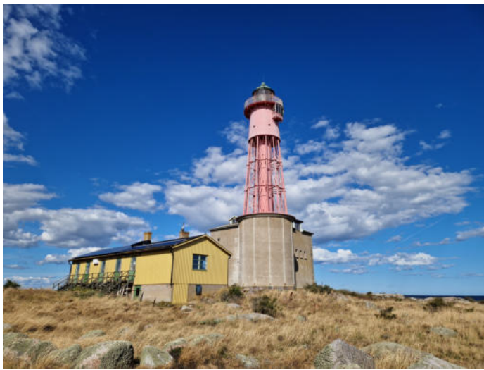
Der Leuchtturm von Utklippan
